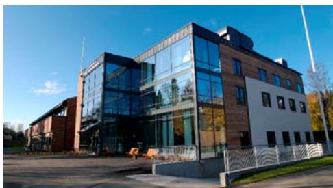
Nordraaksvei Bo- og Behandlingshjem KNX-prosjekt, omsorgsbolig
