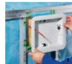
Installasjon med utenpåliggende lekt.
