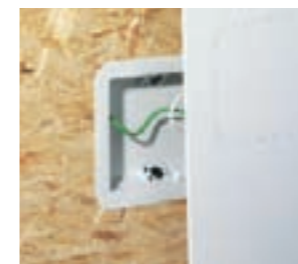
Installasjon med OSB-plate.
