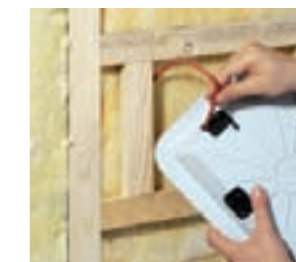
Installasjon med innenforliggende lekt.
